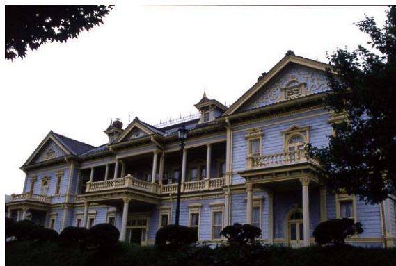
写真 1-10 1982（昭和 57）年の保存修理工事により、創建当初の、外壁がブルーグレー、窓枠・柱型等が黄色の鮮やかな配色に復原された旧函館区公会堂。（1983（昭和 58）年、野口孝博氏撮影）
