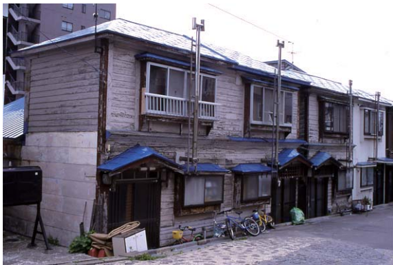
写真 7-6 ペンキ塗り替え前の No. 15. 小笠原家住宅（左手前）と No. 16. 川又家・橋田家住宅（右手奥）－ 2 件とも外壁・胴蛇腹はクリーム系の色、柱型・窓枠を茶色、小庇を青色に塗り分けていたが、とくに外壁はややくすんだ色で老朽化していた。（1999 年 7 月撮影）
