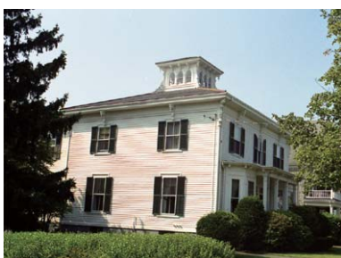
写真 5-12 外壁の白系の事例
