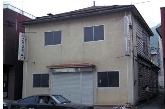
建物の外観 - 正面はモルタル塗りに改修されているが、両側面に下見板他の木部が残っている
