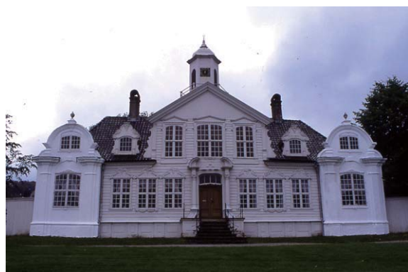
写真 2-4 ノルウェー・ベルゲン市における文化財建造物 Damsgard の外観ファサード 15) (1998年9月撮影)
