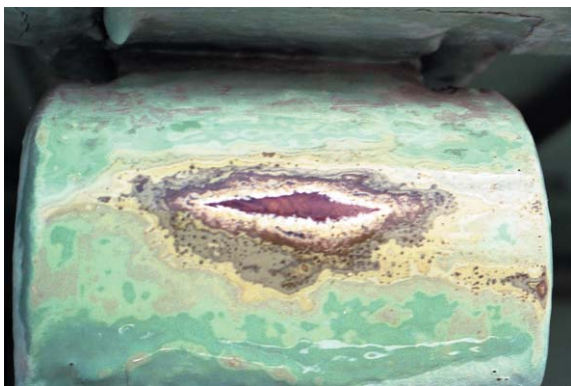
写真3-7 軒持送りペンキ層数最多の時層色環の事例ー No. 37. 相馬株式会社 (1914(大正3)年) 左: 軒持送りペンキ層数最多14層の時層色環、右: 建物の外観
