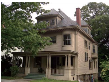
写真 5-10 外壁のベージュ系の事例
