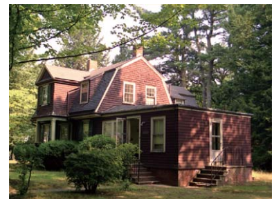
写真5-8 外壁の茶系の事例
