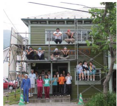
写真 7-1 市民ボランティアによる 2005 年の MOSSTREES（1907（明治 40）年建設、大町）のペンキ塗り替え直後の様子。地元の大学生ほか、延べ 98 人/2 日の参加をみた。（2005 年 7 月撮影）
