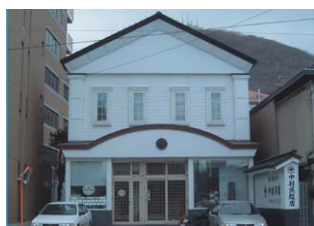
2001年の状況－建物取り壊し、建替新築（サイディング貼り）
