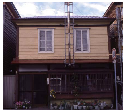
ペンキ塗りの後に、建物所有者が屋根と1階下屋庇を葺き替え、柱型等と同じ茶系の色でペンキ塗装をおこなった。(1999年8月撮影)
