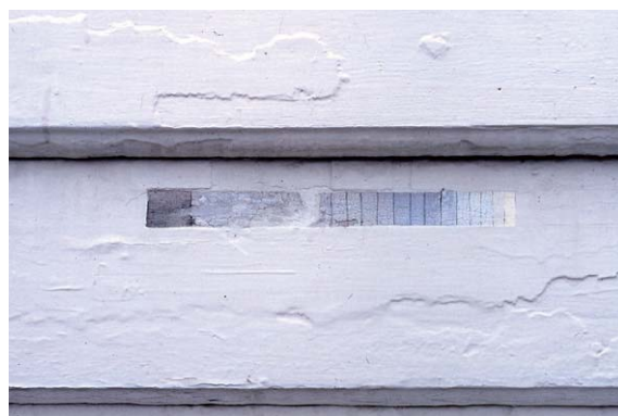
写真 2-5 ノルウェー・ベルゲン市における文化財建造物 Damsgard の外壁下見板のペンキ層ーペンキ層の発掘手法による 15) (1998年9月撮影)
