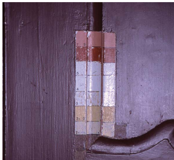
写真 2-3 ノルウェー・ベルゲン市における文化財建造物 Damsgard の室内扉のペンキ層ーペンキ層の発掘手法による 15) (1998年9月撮影)
