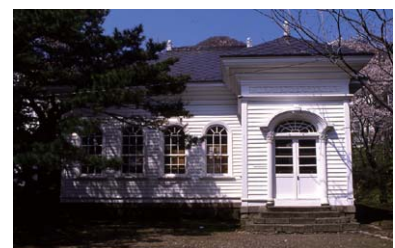
写真 3-9 旧函館県立博物館(第二館、1884(明治 17)年)における白一色のペンキ塗装
