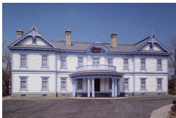
写真 1-12 1986（昭和 61）年の保存修理工事により、創建当初の、外壁が白色、窓枠・柱型等がウルトラマリンブルーの鮮やかな配色に復原された豊平館。財団法人文化財建造物保存技術協会 編『重要文化財豊平館 保存修理工事報告書』（札幌市、1986 年 7 月）より転載。
