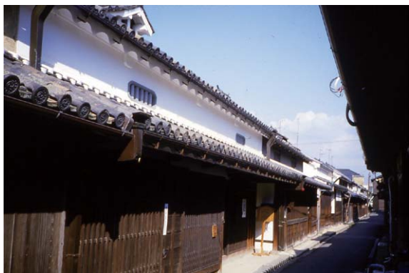
写真 8-3 建物 1 階の木の色と 2 階の漆喰の白色からなる町並みの典型事例ー橿原市今井町重要伝統的建造物群保存地区の町並み（1985 年 11 月撮影）
