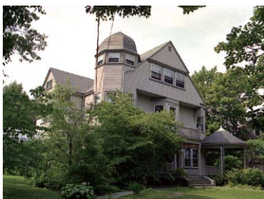
写真 5-11 外壁の灰系の事例
