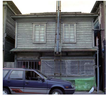
ペンキ塗り替え前の洪田家住宅ー外壁：青灰、柱型・窓枠：濃緑であったが、ペンキはほとんど剥げ落ちていた。(1989年7月撮影)
