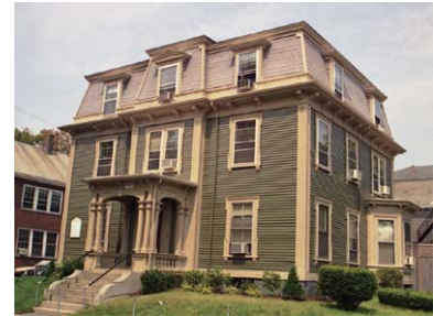
写真5-7 外壁の緑系の事例
