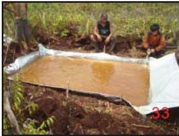
Gbr 33. Penampungan air untuk mereli mesin pompa (13 Agustus 2009)
