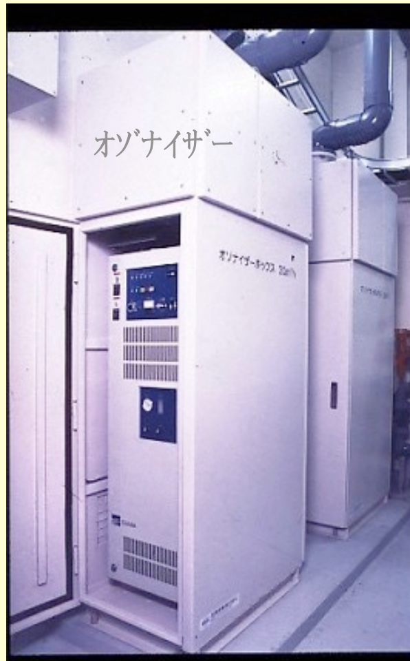
Ozon treatment unit: オゾン殺菌装置 (オゾナイザーとインジェクションタワー)
