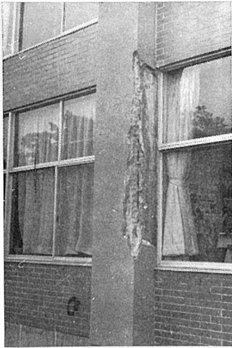
写真-13 根室支庁外壁柱
