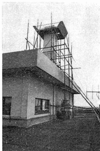
写真-10 根室電報電話局煙突外観
