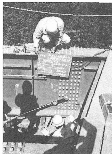
写真11 本締めめのボルトのトルク値確認
