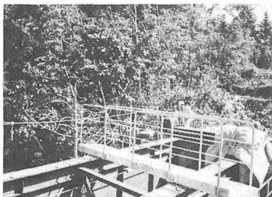
写真6 継手部の鉛直沈降量をレベルで測定(1)
