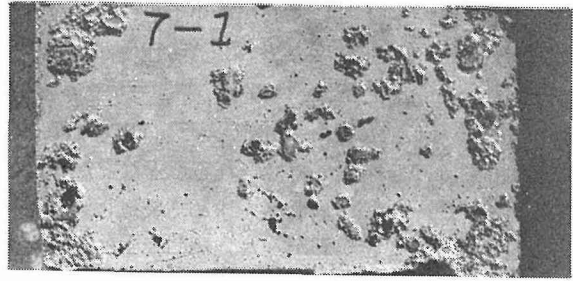
写真-7 剥離損傷状況(凍結融解試験)
