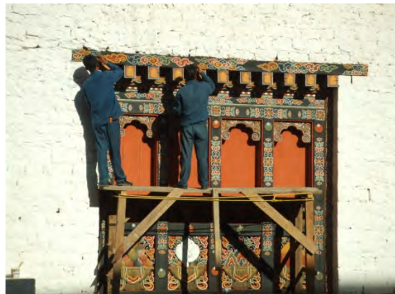
伝統建築物の修復作業（プナカ・ゾン）
