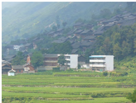
青曼村のコンクリート建造物
