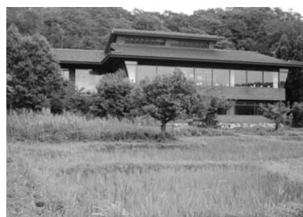
写真・13 鴨池側から見た鴨池観察館
