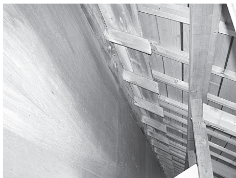
図74 増築部分繋ぎ目に残る庇 2004年7月撮影
