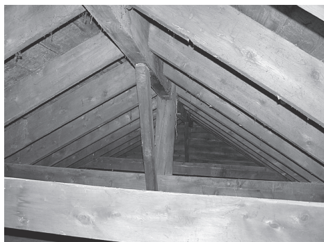
図73 倉庫内部屋根部分 2004年7月撮影
