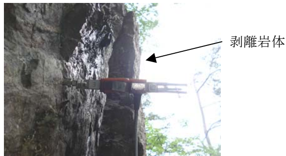
図1 剥離しそうな岩体に設置した亀裂変位計 No. 3
