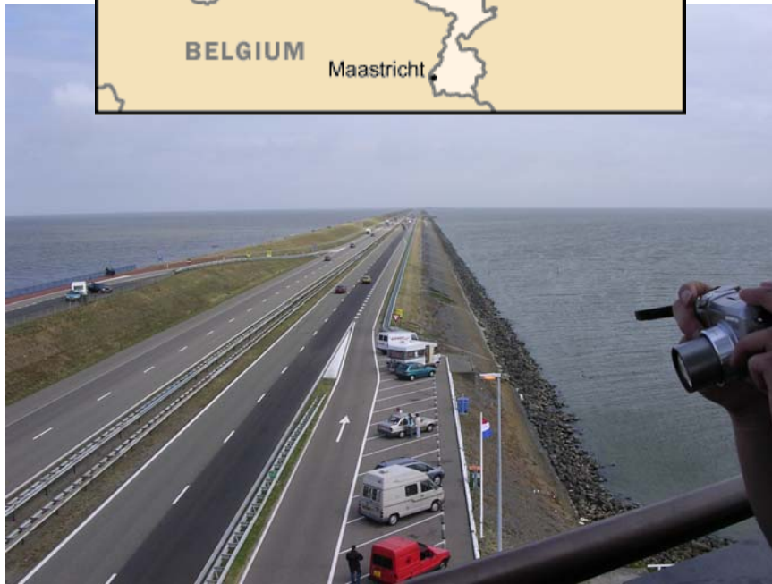
大堤防 Afsluitdijk(オランダ北部)
