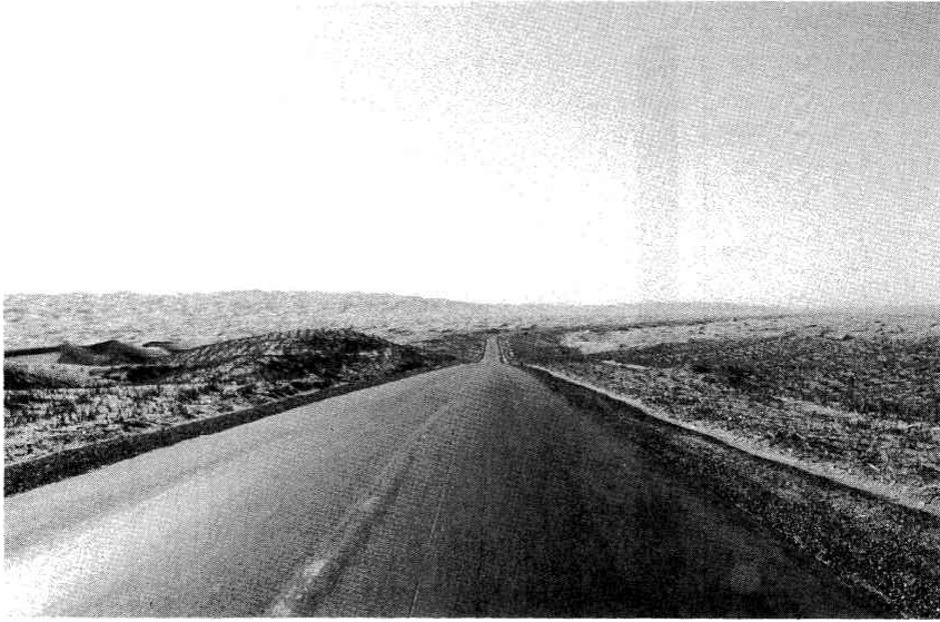
図8. タク라마カン砂漠縦断道路. 1991年10月開通. ブグルーニヤ間を走る(図1参照). 南北約200 kmの砂漠がつづく. その間, はとんど植物も見ることにはできない. 道路の両側には, アシの茎が差し込まれ, 風で砂が吹き飛ばされないような処置が施されている.
