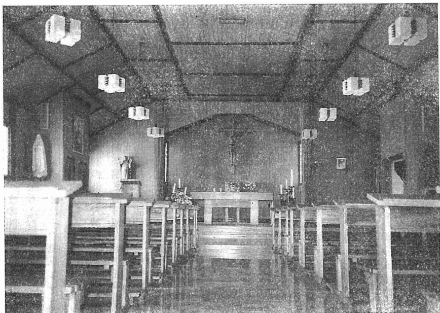
写真—3 現聖堂内部（昭和31年建設）
