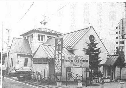
現会堂 (S38・壁RC造木造小屋平家建)
