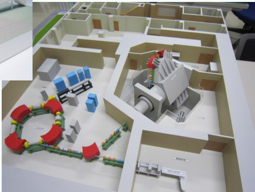
北海道大学分子追跡 陽子線治療施設 建屋内部(加速器、回転ガントリー)
