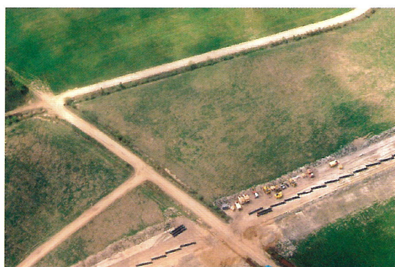
7-7 天然ガスパイプライン終点の液化プラント・積み出し基地プリゴロドノエ（女麗）に向かうパイプライン工事（コルサコフ北上空より撮影）
