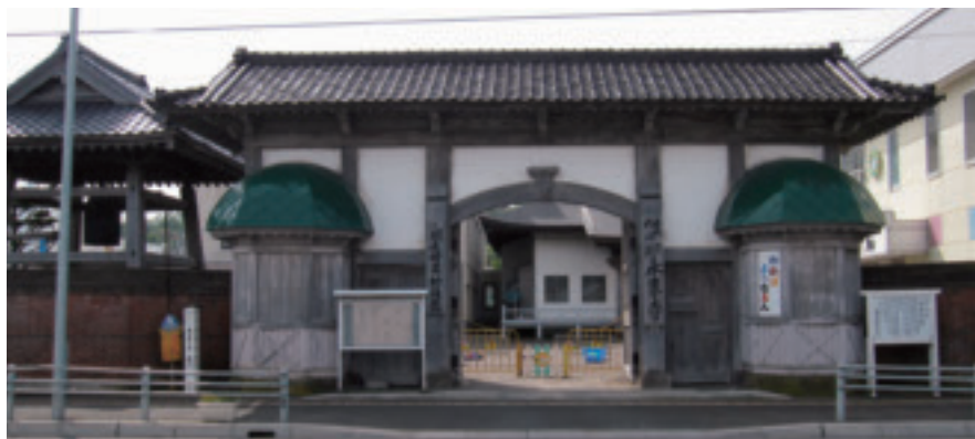
■ 写真4. 永専寺山門
