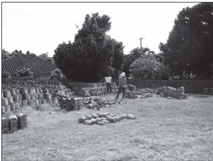
写真1-8 屋敷を利用した赤瓦のストックヤードと瓦チェック
