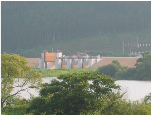
旧北上川分流施設 現在改築が進んでいる。
