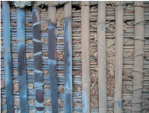
この上に壁土をぬり仕上げる。 ヨシを使った小舞
