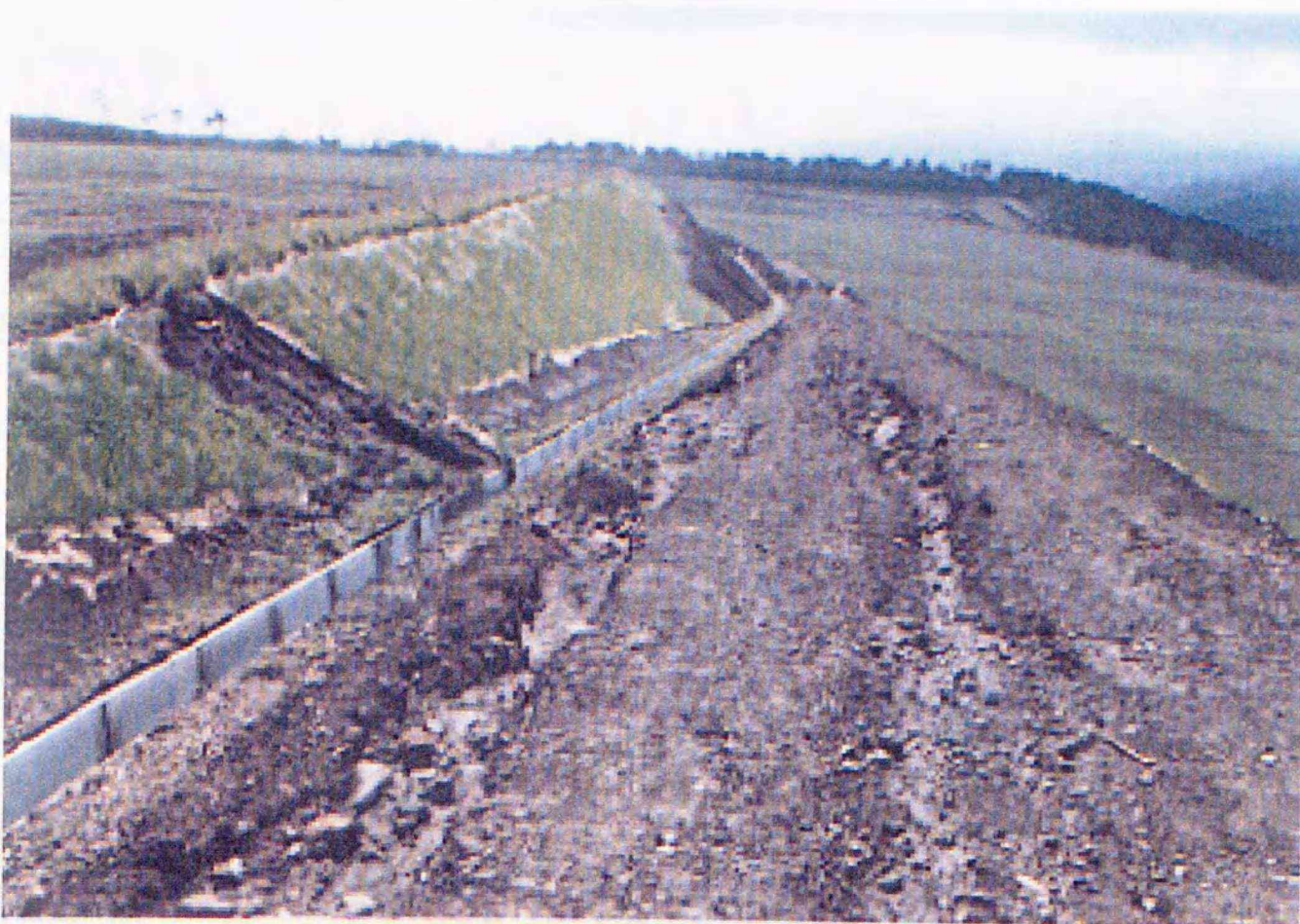
写真-2-1 耕作道路の土壌侵食 (1985.11)
