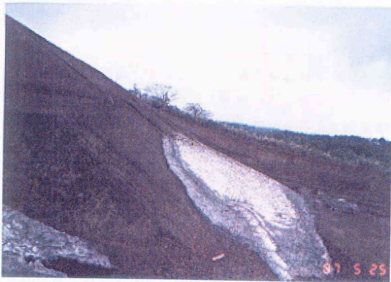
写真-2-9 1986年度造成圃場春先の承水路 (1987.5)
