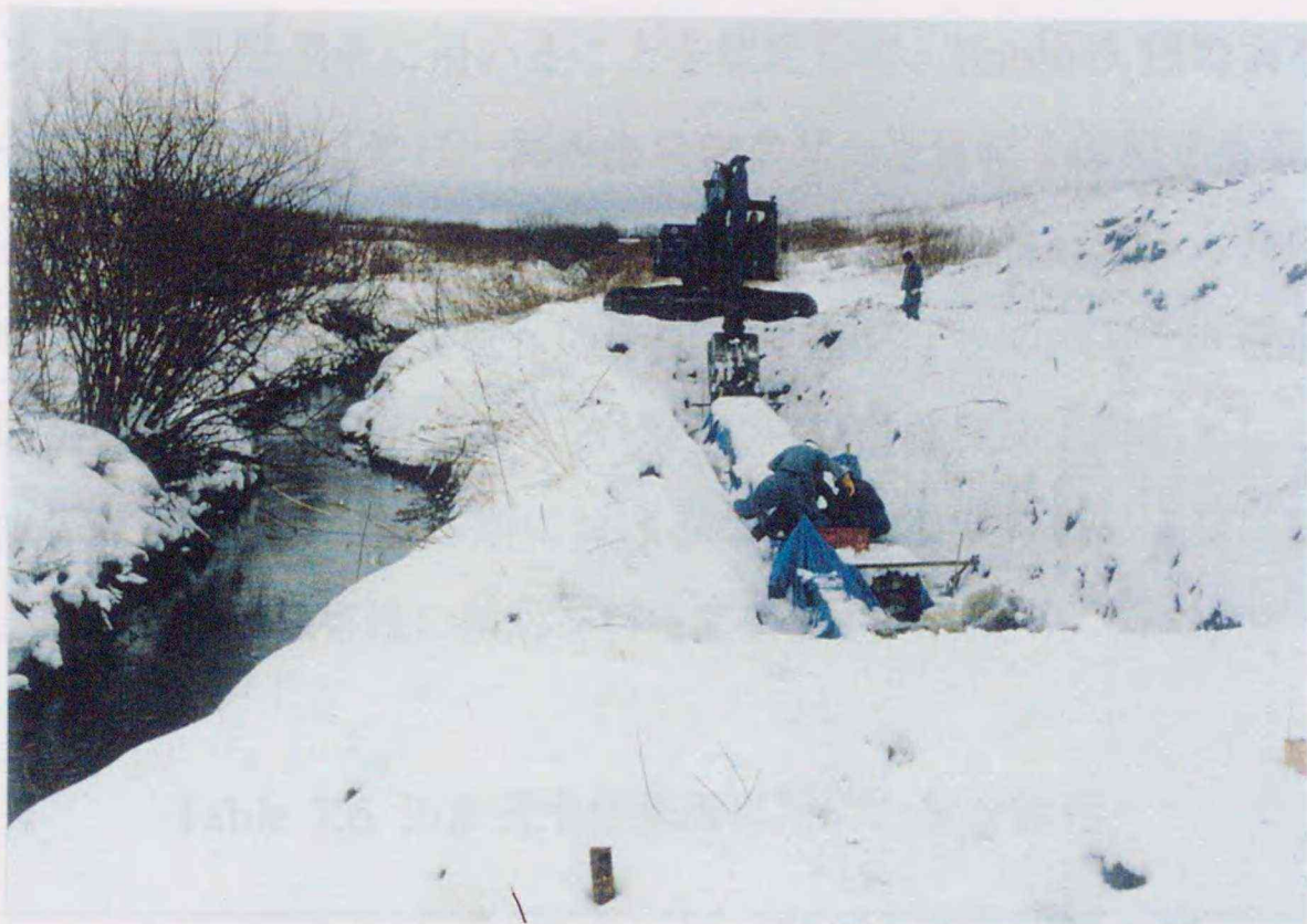
Photo 5.13 埋設護岸の施工状況(その1)
