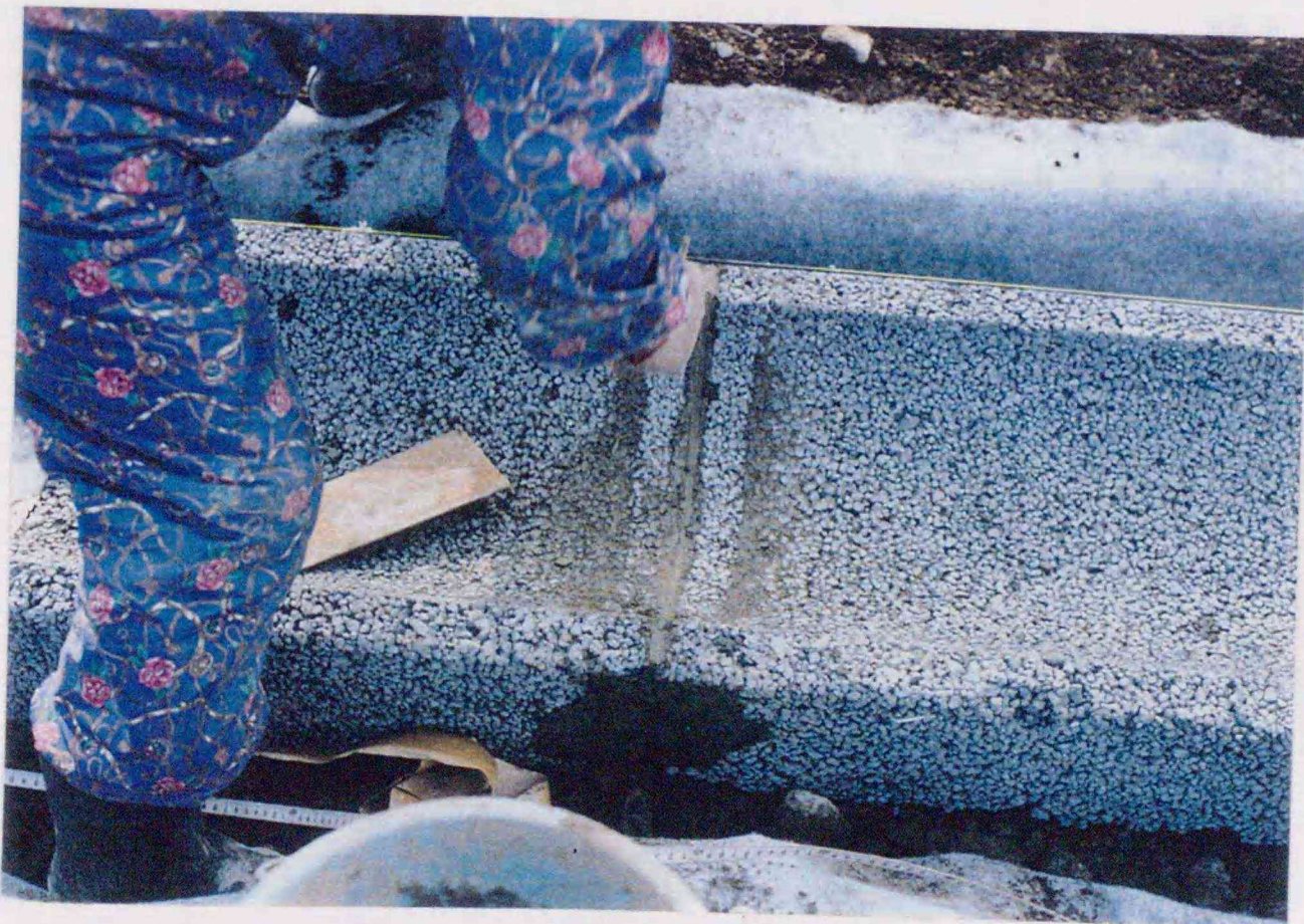
Phpto 5.19 施工状況(モルタルによる目地止め)
