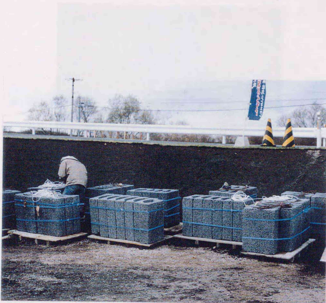
Phpto 5.18 施工状況(温度およびひずみ測定用結線)
