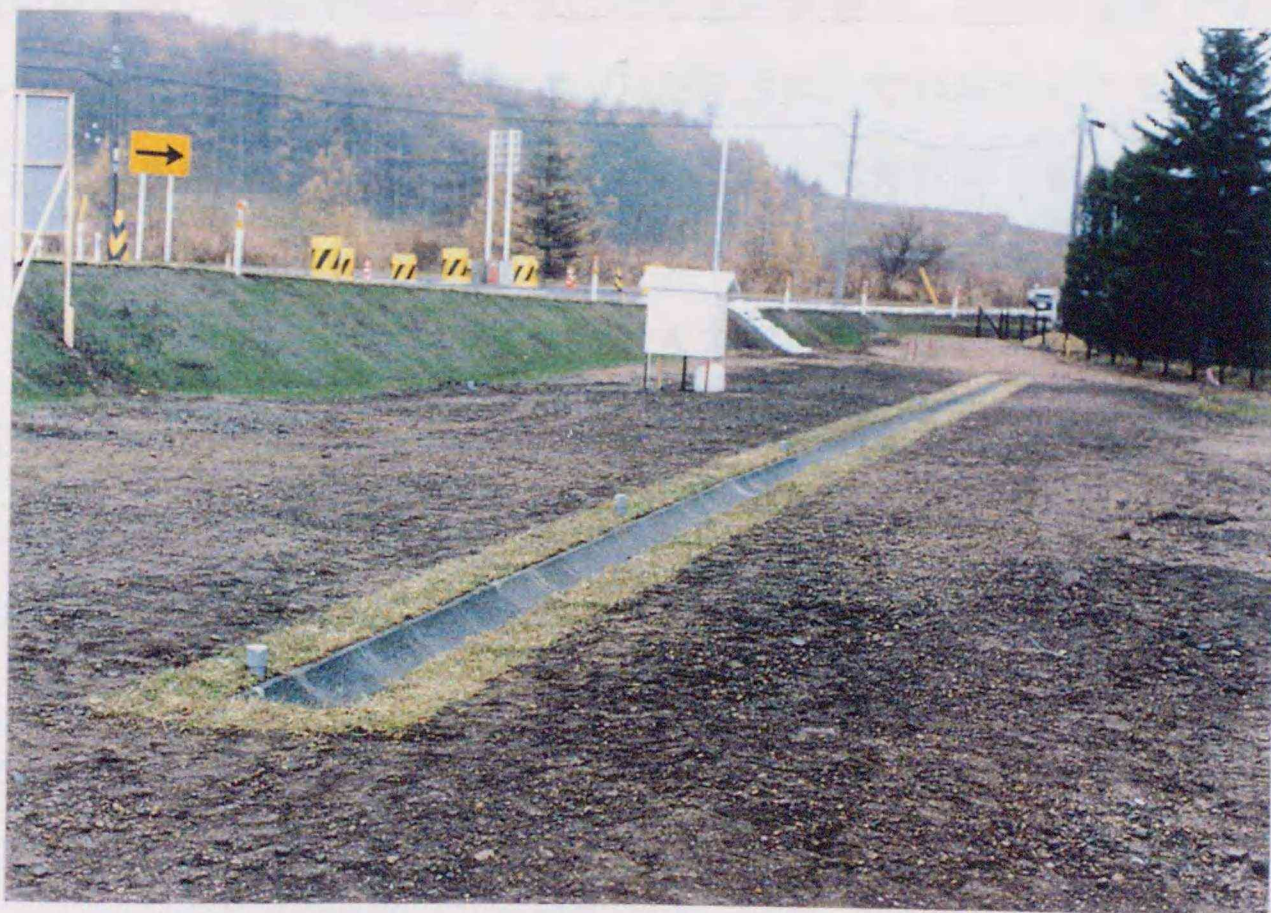
Phpto 5.21 試験施工完了
