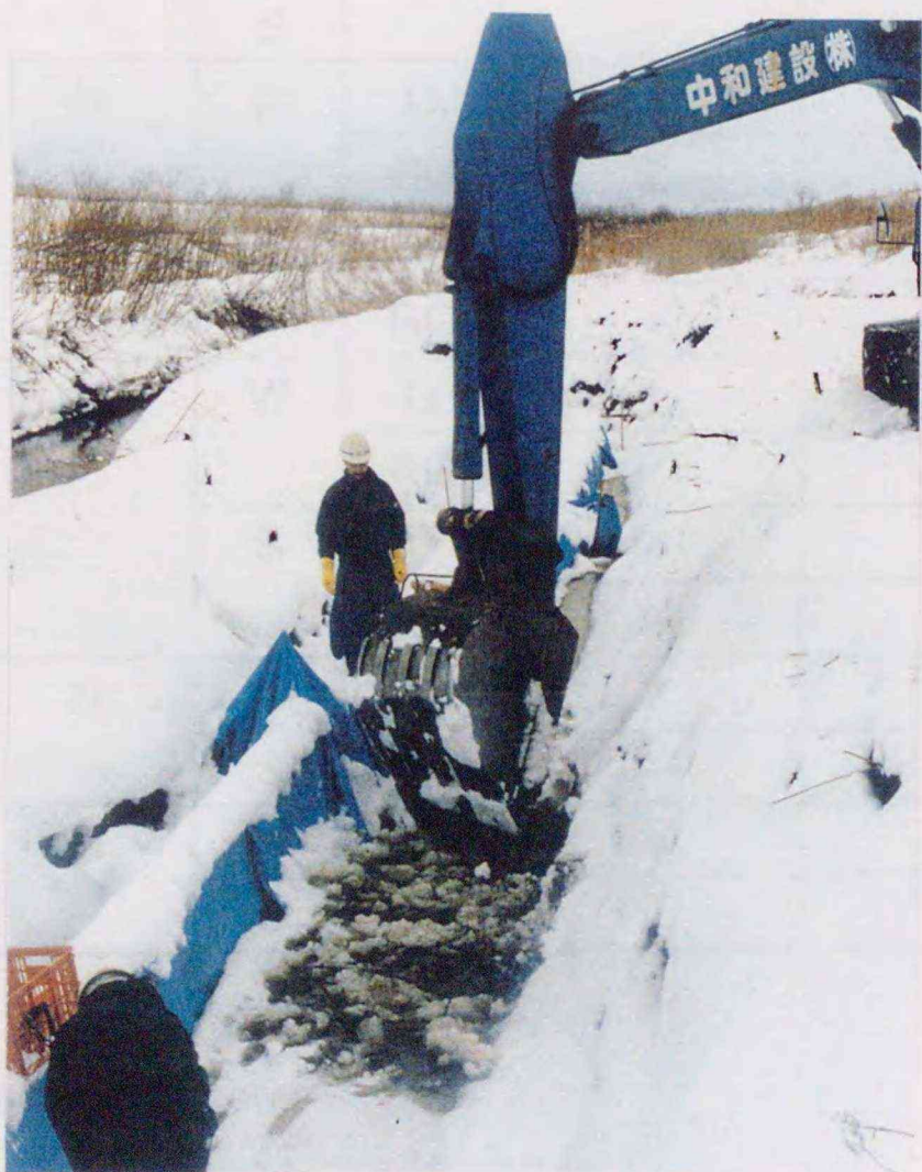
Photo 5.14 埋設護岸の施工状況(その2)
