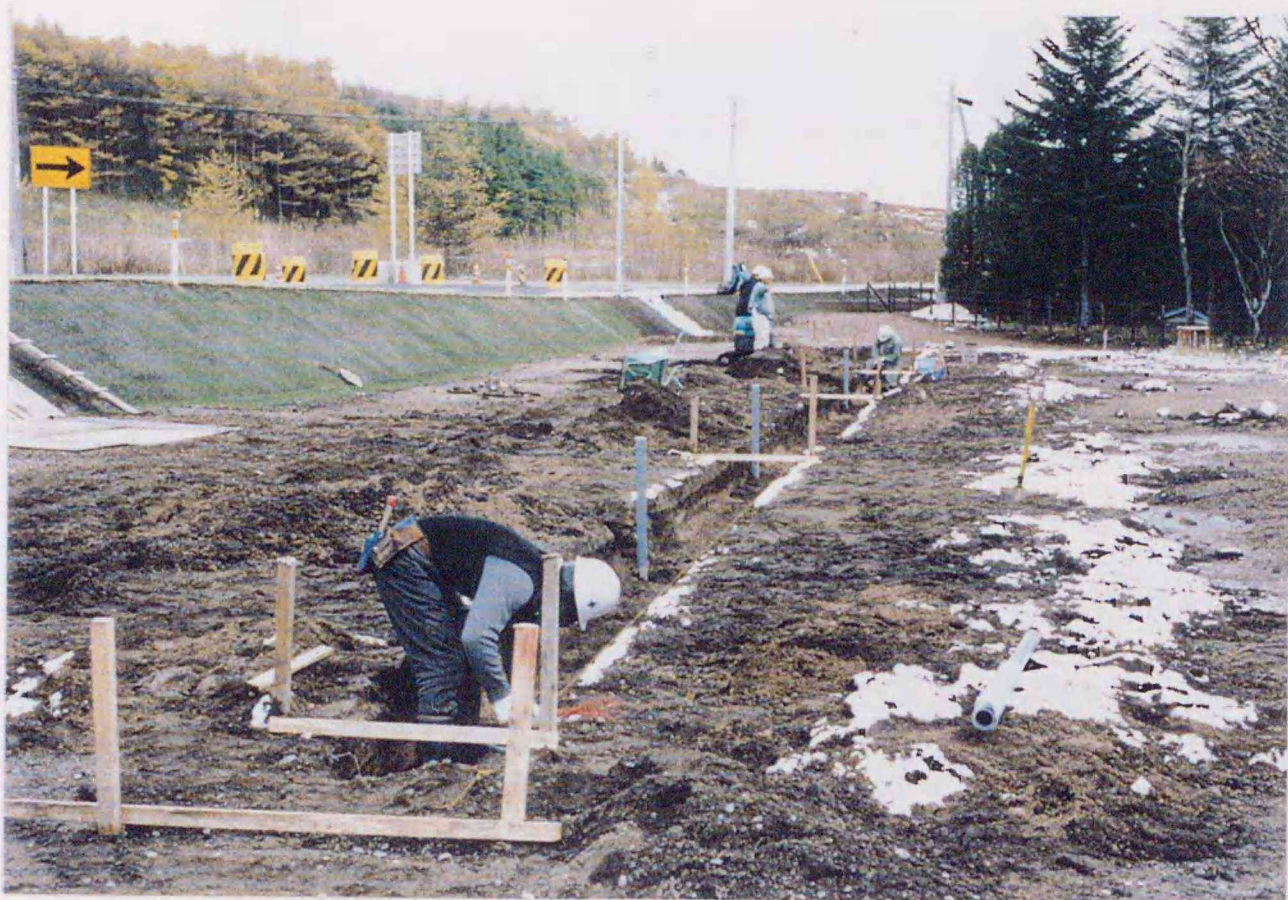
Phpto 5.16 施工状況(路盤材下に透水シートを設置)
