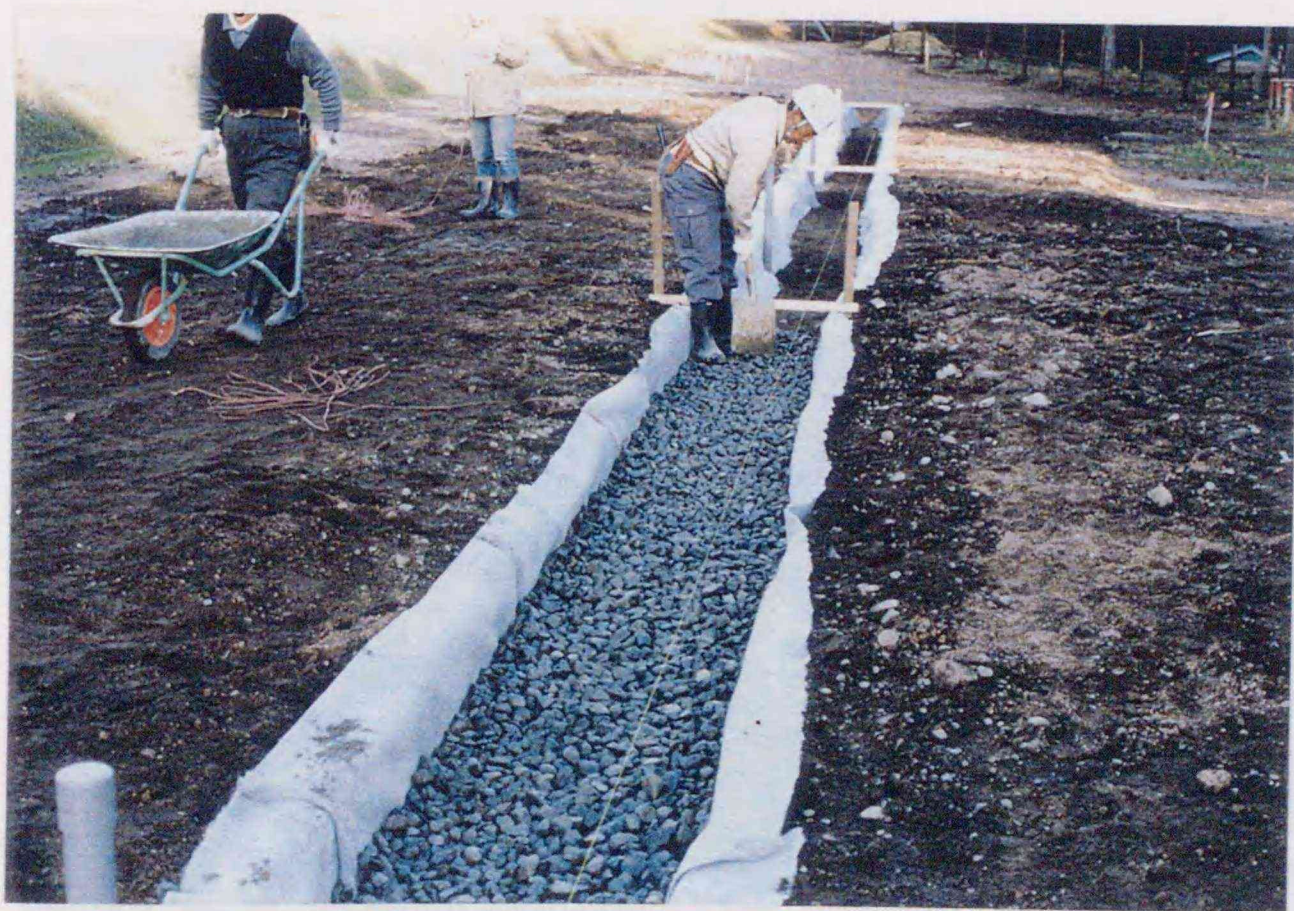
Phpto 5.17 施工状況(透水シートを設置し路盤材を敷設)
