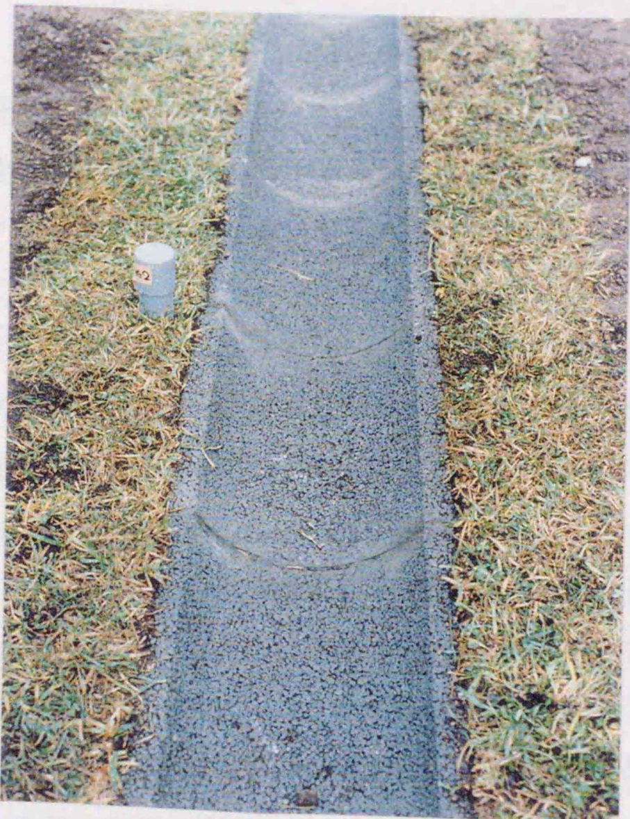
Photo 5.20 側溝周囲に芝を張り実施工時と同様な環境を与える
