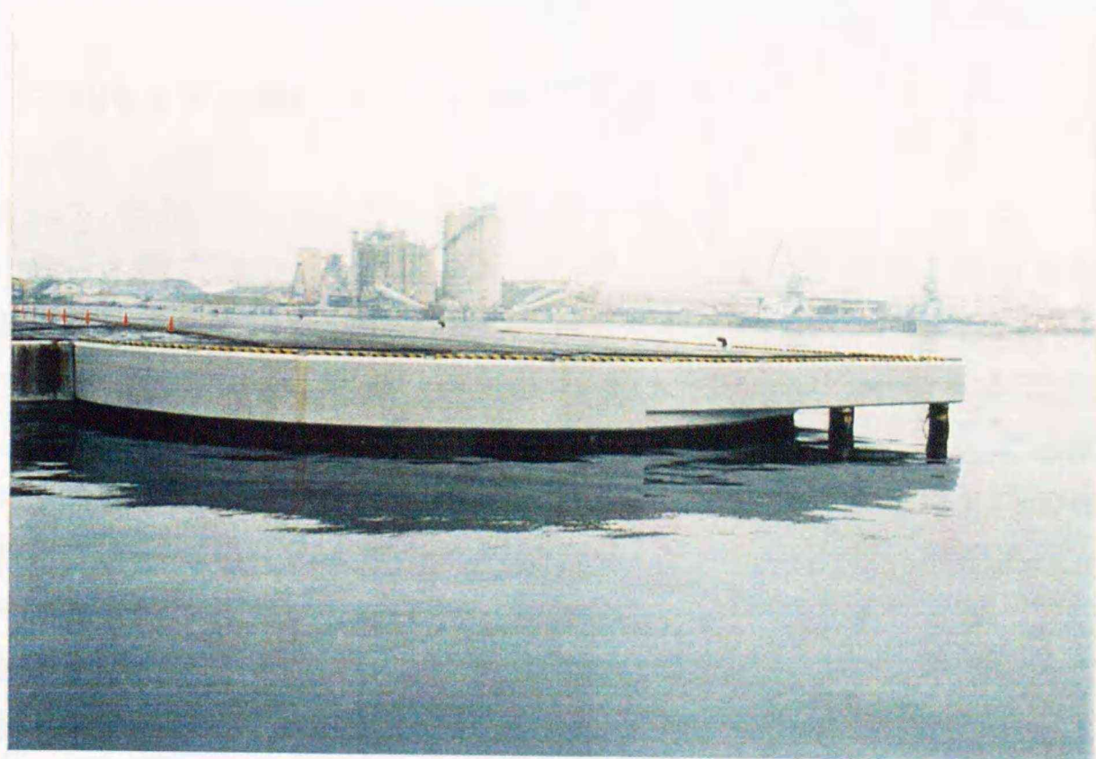
写真-3.3 補修後の栈橋
