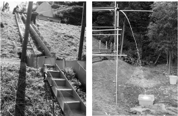
(a) 現地水路試験の状況 (b) 現地自由落下試験の状況 写真-2 現地試験の状況 (In situ channel and water falling experiments)
