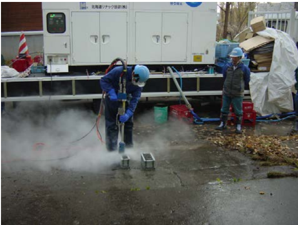
写真 2.1 ウォータージェット施工 (1)
