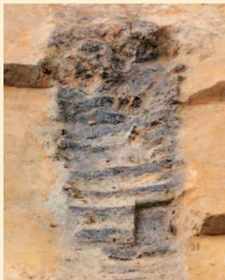
▲煙道から検出された炭化した板材 (1枚の板材の大きさ:約40cm×10cm)
