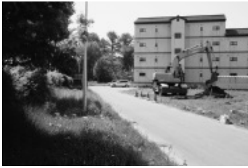
A. 留学生会館周辺埋設管その他工事予定地 TP 01 調査状況（南より） 0704
