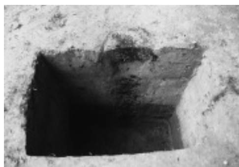
2. HP 01 SPT 03 (断面状態：南より)
