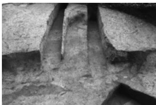
H. HP 01 カマド完掘（北より）
