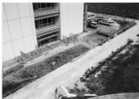
8 東区調査状況（南西より）
