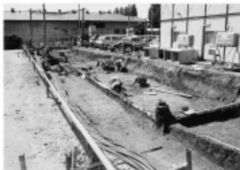
4 西区調査状況（東より）
