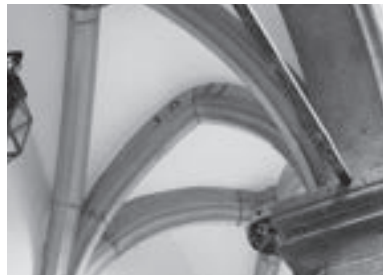
4. Die Schlusssteine in der Torhalle des Kempenischer Hauses
