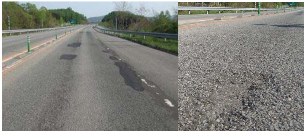
写真 5-4 除雪作業による高機能舗装Ⅰ型の摩耗と骨材飛散状況
