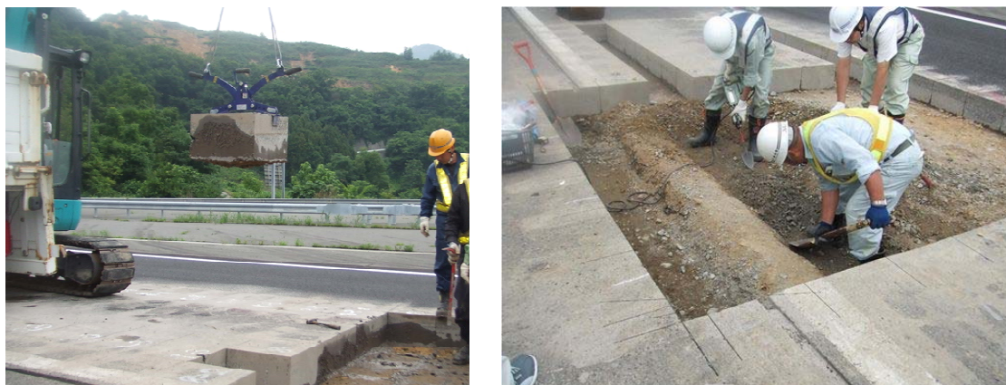
写真 4-11 開削調査の作業状況
