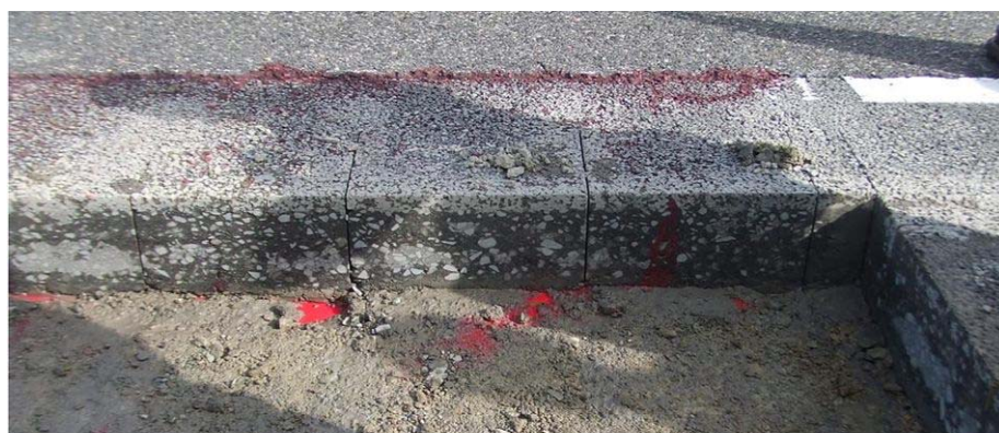
写真 4-15 ポンピング発生個所の水みち
