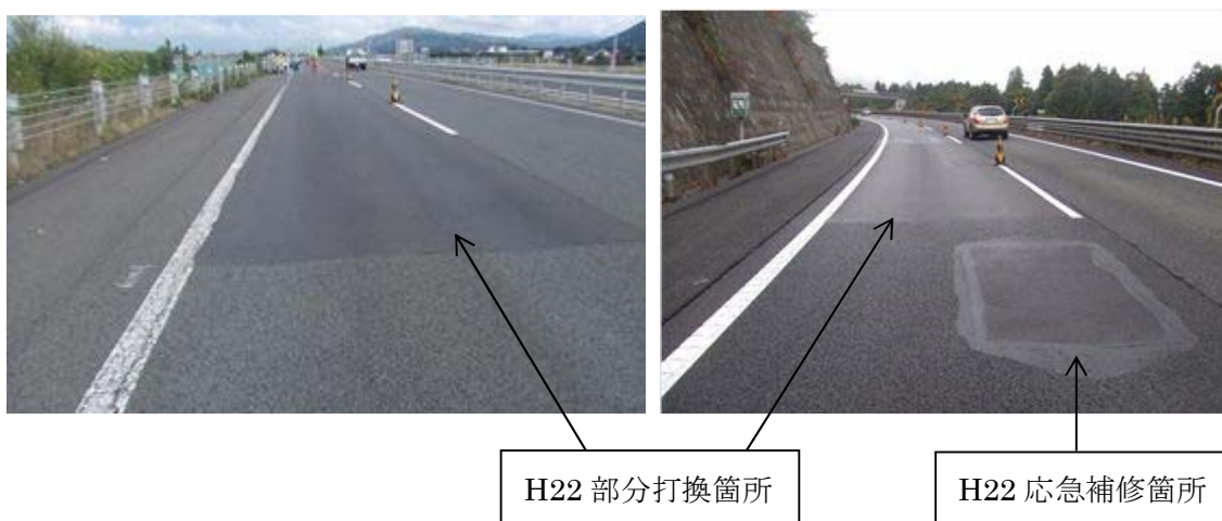
写真 4-10 開削調査箇所の路面状況（左：A工区、右：B工区）
