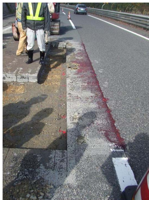
写真 4-14 施工目地への着色水の流し込み
