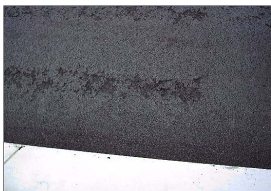
写真 3-5 レベリング層における混合物の引擦り
