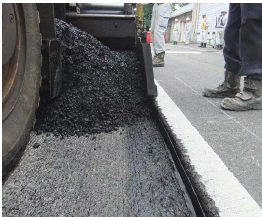
写真 5-12 切削断面にアスファルト止水テープを貼付け、舗設を行っている様子
