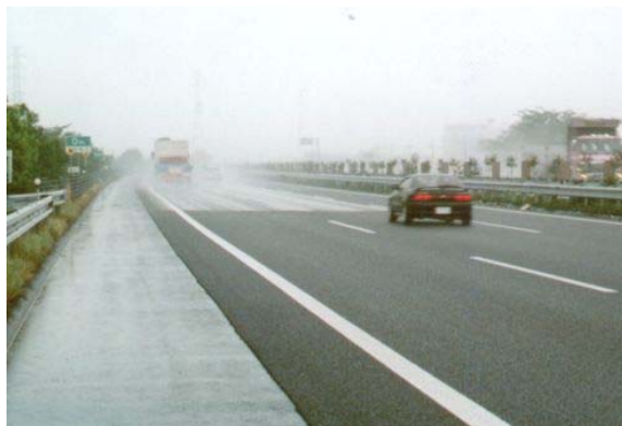
写真 3-6 雨天時の視認性の違い (手前が高機能舗装、奥が密粒舗装)
