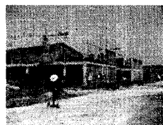
写真 1 新村の工事現場
