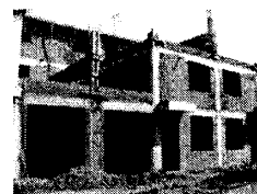
写真 2 中層住宅建設現場
