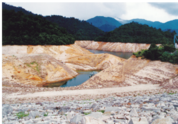
図2：1994年夏の渇水時の矢木沢ダムの風景（利根川ダム統合管理事務所提供）
