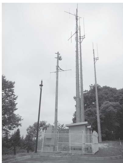
図1. 浦幌町東山の通信鉄塔
