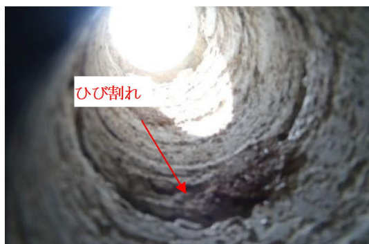
写真 5-26 G 部 コア削孔断面
