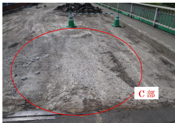
写真 5-19 第3径間の床版上面の状況
