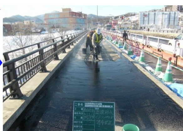
写真 3-7 塗膜系防水材の塗布
