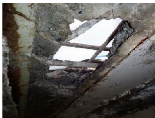
写真 5-3 抜落ちの状況（下面から） (資料提供；(独) 寒地土木研究所)
