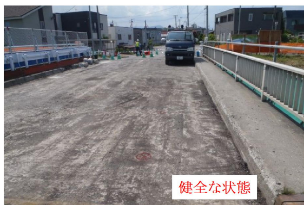
写真 5-17 第1径間の床版上面の状況
