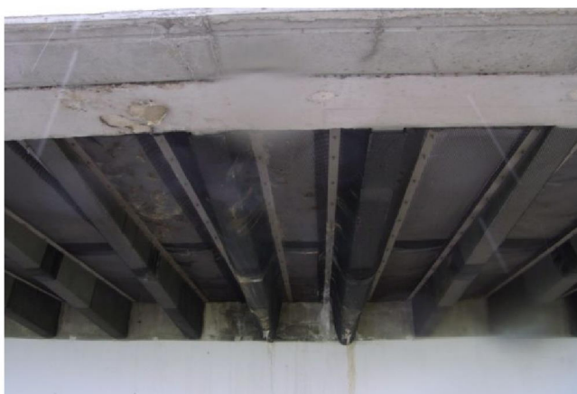
写真 3-8 剥落防止の状況
