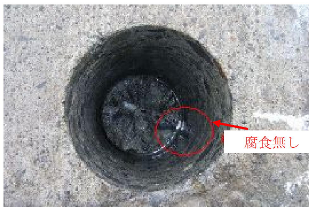
写真 5-8 コア採取箇所の鉄筋の状況
