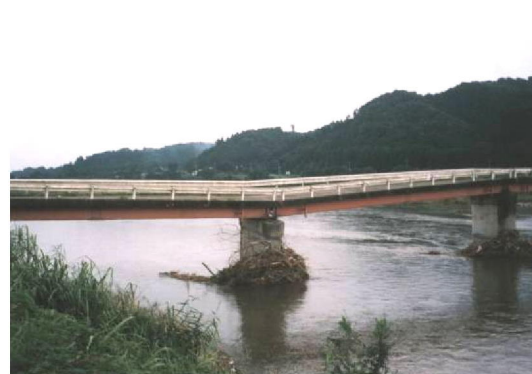
写真 4-4 橋脚の沈下
