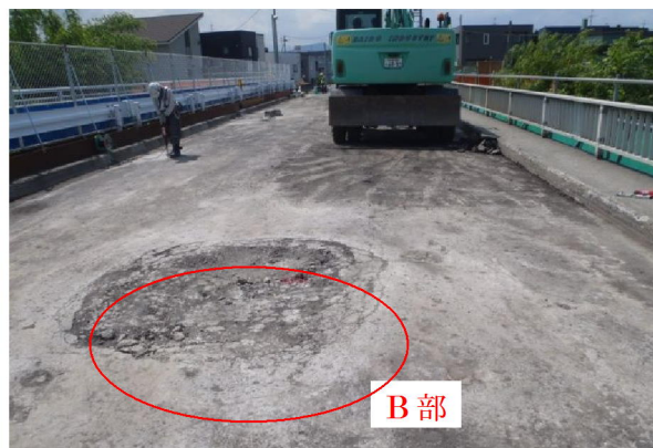
写真 5-18 第2径間の床版上面の状況
