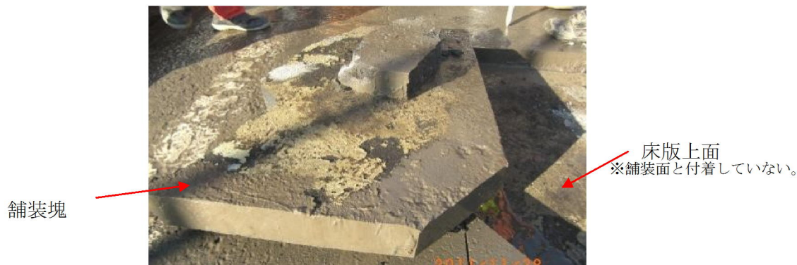
写真 5-13 舗装切削状況
