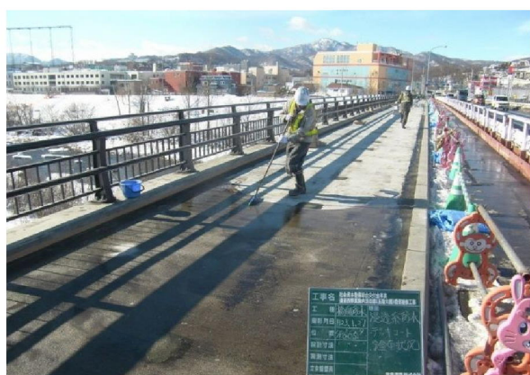
写真 3-6 浸透系防水材の塗布
