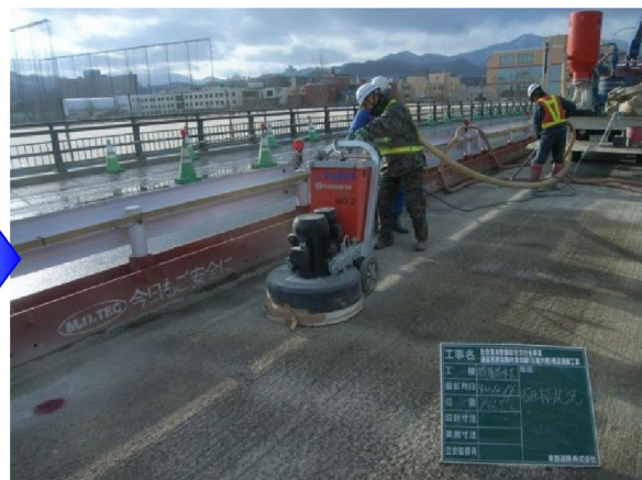
写真 3-5 研掃作業（脆弱部の処理）
