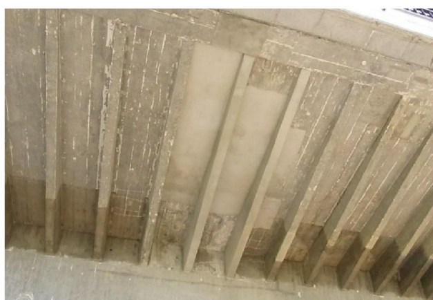
写真 3-10 補修後の状況
