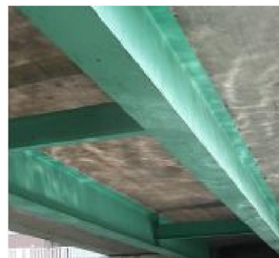
写真 3-3 新あかつき橋 (1963 年架設)
