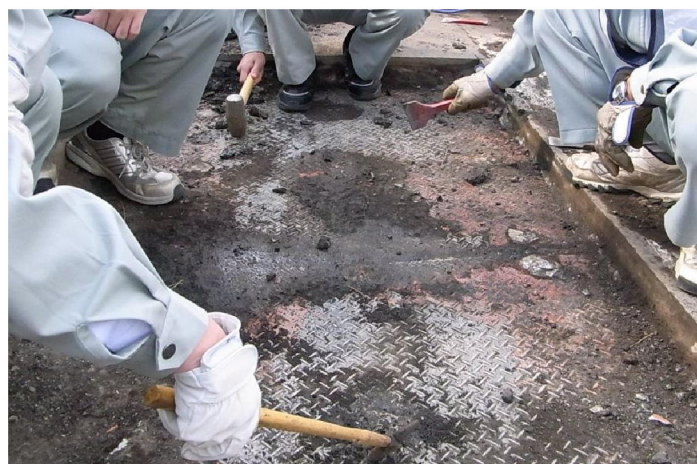
写真 5-14 舗装開削の状況
