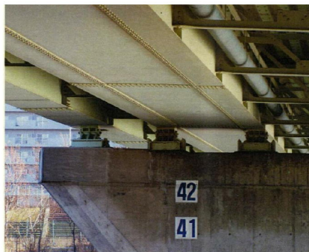
写真 3-2 南 22 条大橋 (1961 年架設)
