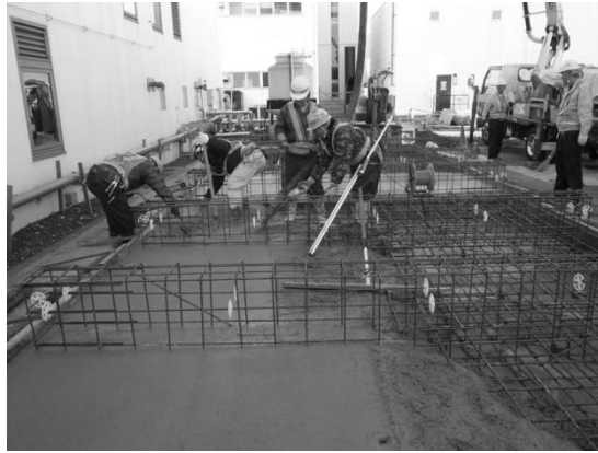
図 5.21 スラブへの打込み状況
