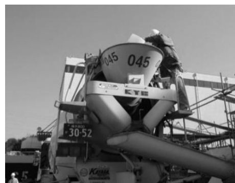
トラックアジテータに新 SRA を投入・ 攪拌する製造方法（シリーズ 2）
