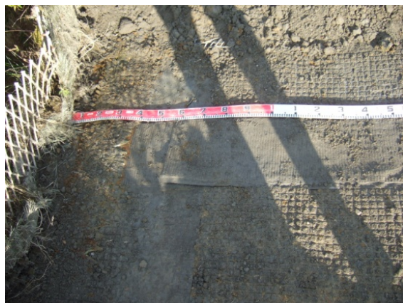
(a) 壁面付近の状況（箇所1 深さ1m）
