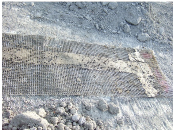
(b) 補強材取り出し状況（箇所1 深さ1m）
