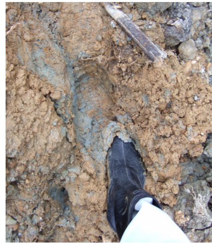
(b) 崩積土の状況
