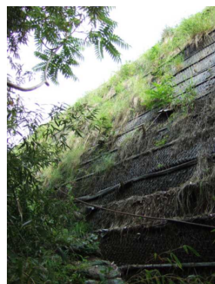
(b) 壁面状態（箇所1）
