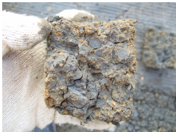
(d) 盛土材料の状況（箇所1 深さ1m 壁面側）
