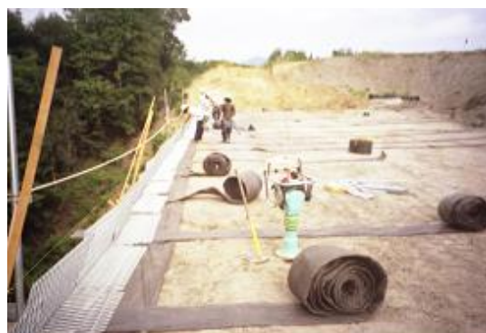
図-3.3.6 施工時の水平排水材設置状況
