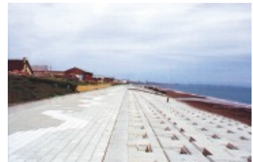
SIM 3-2 植栽を施し、緩傾斜護岸に 砂浜を付けた
