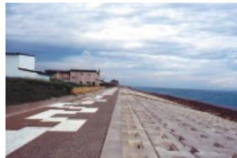
SIM 2-1 緩傾斜護岸と植栽を施した
