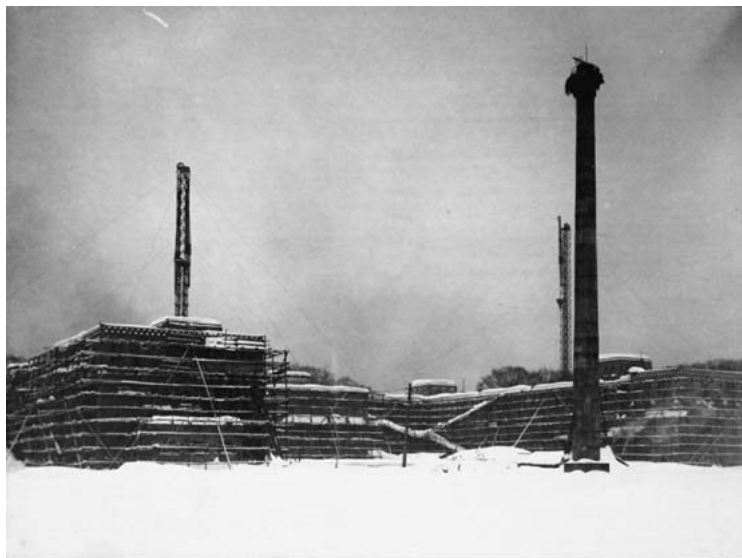
写真8 コンクリート打ち込み中の理学部本館
