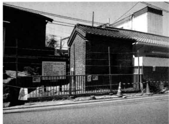
図2 旧東海道線稲荷駅危険品庫(京都府京都市伏見区深草稲荷御前町) 2011年4月5日 内田祐一氏撮影・提供
