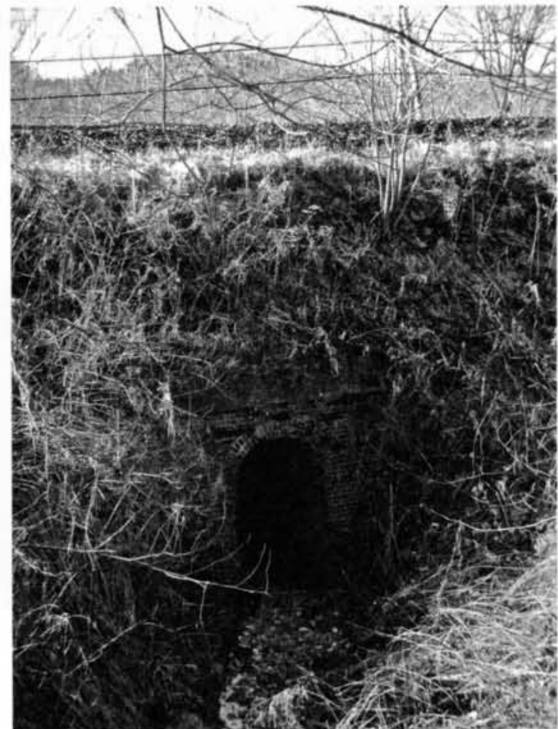
図9 上厚内～厚内間に設置されている暗渠タイプアーチ橋 (2013年筆者撮影)
