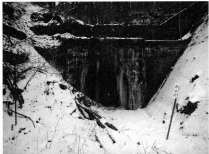
図7 旧厚内トンネル上厚内側坑門（2014年筆者撮影）
