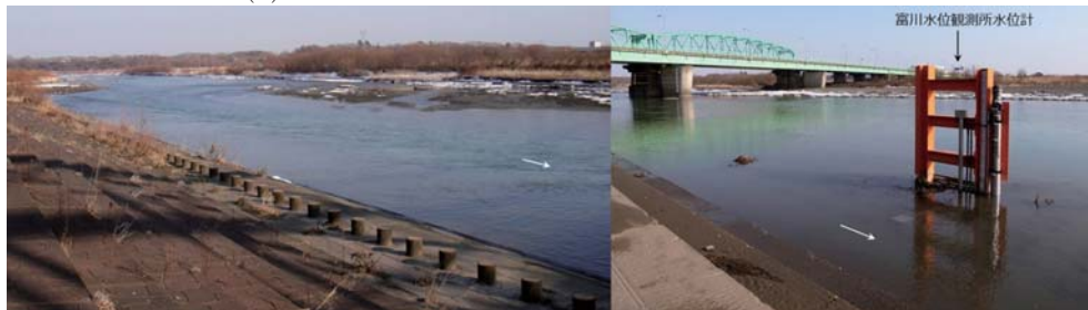
(b) 富川水位観測所付近の河川の状況 (KP.2.7)
