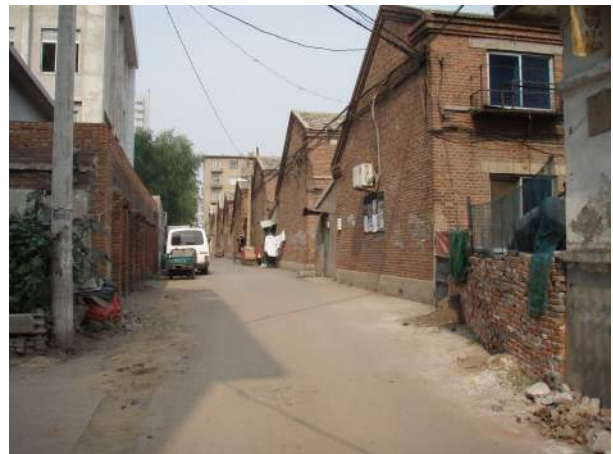
写真 3-5-4 奉天の旧満鉄社宅 その 4 (2011 年撮影) この社宅は皇姑区にある皇姑屯駅北側に位置する。建物はレンガ造の 2 階建てのテラスハウスである。各住宅に独立した厨房とトイレが整備されている。
