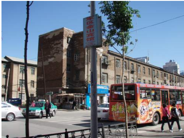
写真 3-5-1 奉天の旧満鉄社宅 その 1 (2011 年撮影) この社宅は和平区にある瀋陽駅の東北側に位置する。建物はレンガ造の 3 階建ての集合住宅である。各住宅に独立した厨房とトイレが整備されている。
