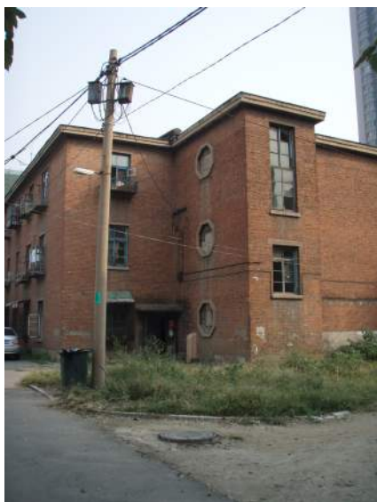
写真 3-5-5 奉天の旧満鉄社宅 その 5 (2011 年撮影) この社宅は皇姑区にある皇姑屯駅北側に位置する。建物はレンガ造の 3 階建ての集合住宅である。共用住宅であり、各階に共用の厨房とトイレが 2 箇所に整備されている。
