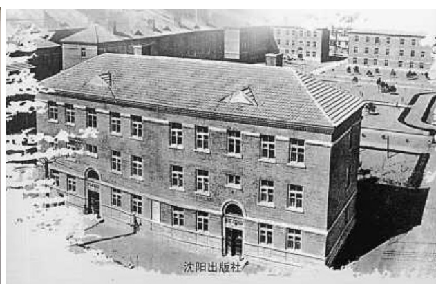
図2-4-2「鉄西工人村」の住棟（出典：『工人村』 39) ） 図は温恕著『工人村』（瀋陽出版社、2012.3、ISBN：9787544149259）より転載したものである。建物は、レンガ貼りの外装で、アロプーチを2つつつ3階建ての板状集合住宅である。
