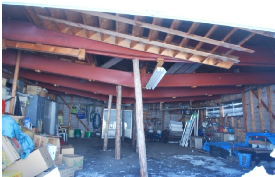
図 32. 丸太で Bj 氏家屋屋根の倒壊を防ぐ (2012 年 2 月 19 日筆者撮影)
