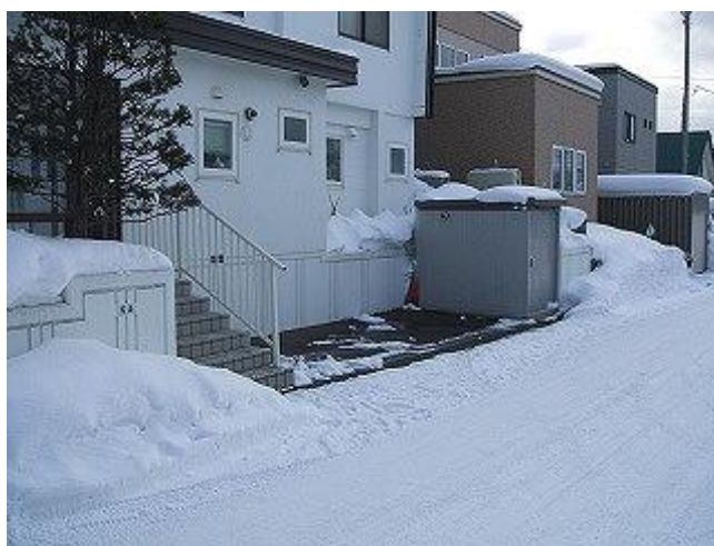
写真 2-5-3 ロードヒーティング
