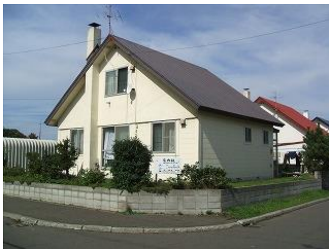
写真 2-10-1 現存する開発当時に建設された三角屋根の補強ブロック造住宅
