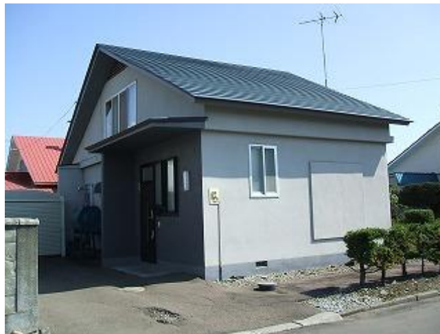
写真 2-7-1 現存する開発当時に建設された三角屋根の補強ブロック造住宅
