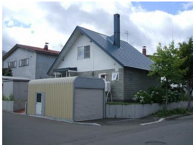
写真 2-9-1 現存する開発当時に建設された三角屋根の補強ブロック造住宅
