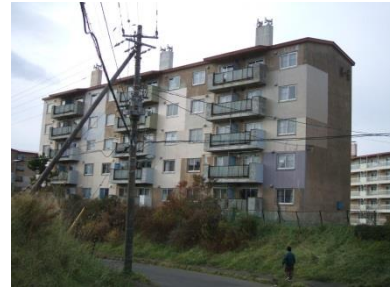
老朽化した市営住宅
