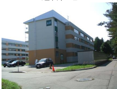
全面改善した道営住宅
