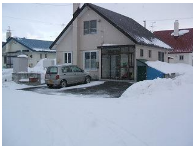
写真 2-10-2 ロードヒーティング
