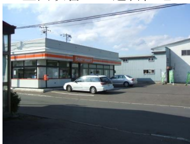
コンビニエンスストア 写真 2-7-1 大空団地の状況
