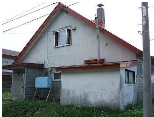
写真 2-8-1 現存する開発当時に建設された三角屋根の補強ブロック造住宅
