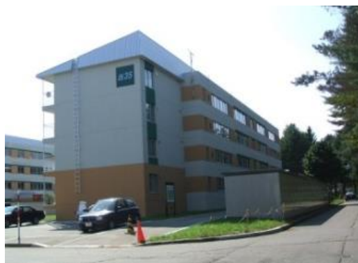
写真 5-3-2 全面改善した公営住宅
