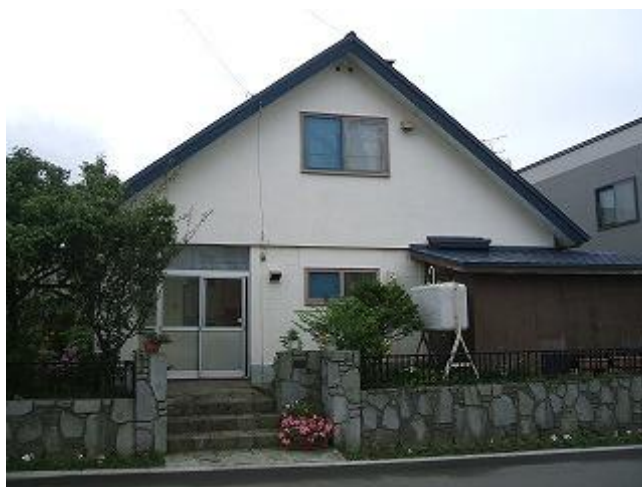
写真 2-5-2 現存する開発当時に建設された三角屋根の補強ブロック造住宅
