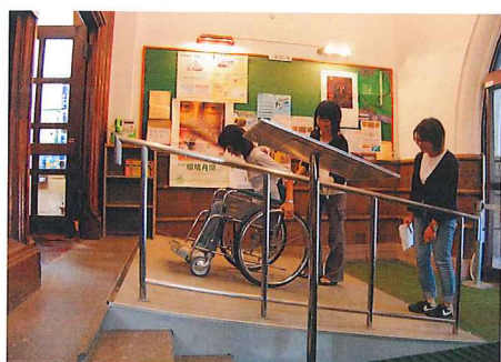
傾斜が急な玄関のスロープ
