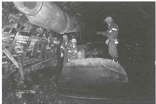
ベトナム人技術者を対象とした坑内での研修
