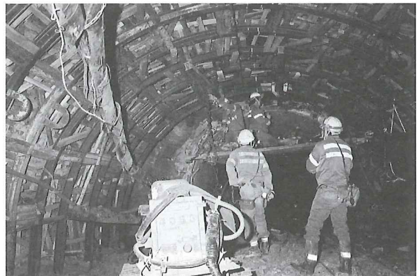
坑道を維持するため、坑道を支える鉄枠を設置する 〈写真提供：石川孝織〉
