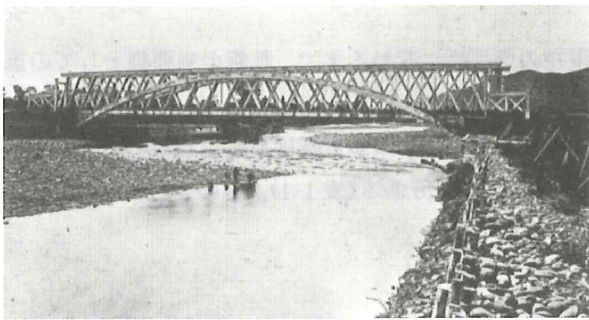
図1-11 豊平橋横断面(ホイラー修復)(明治11年) (北海道大学附属図書館北方資料室所蔵) 破壊されたホルト設計の橋を修復した。
