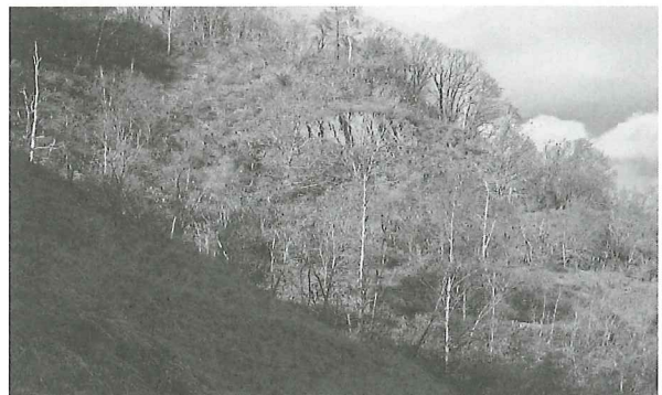
図8-43 デイサイト露頭遠景 藻岩市民スキー場への道路から見た露頭の全体。のり面と小段からなっている。
