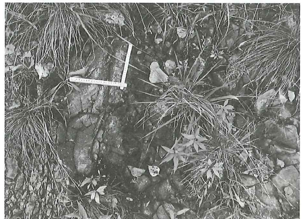
図 8-38 右岸のデイサイト(左)と泥岩の境界部 折尺の右端が境界部である。
