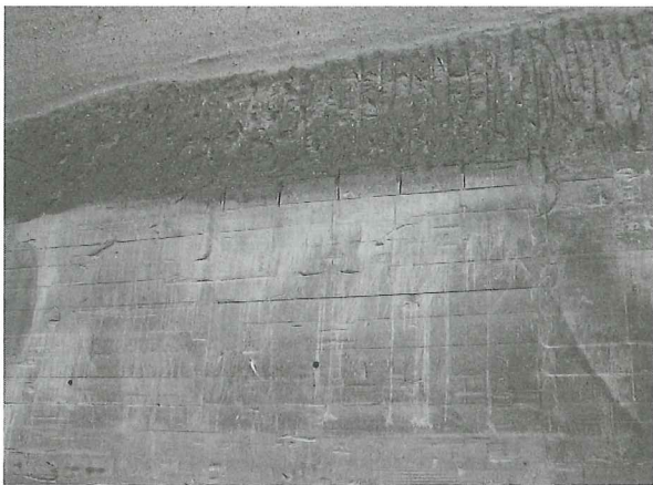
図 8-48 非固結部と漸移部と固結部 漸移部の黒い筋から下には切り出した跡が見える。
