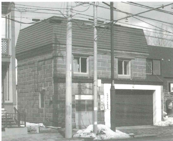
（南区石山） 石山水防倉庫 ＊
