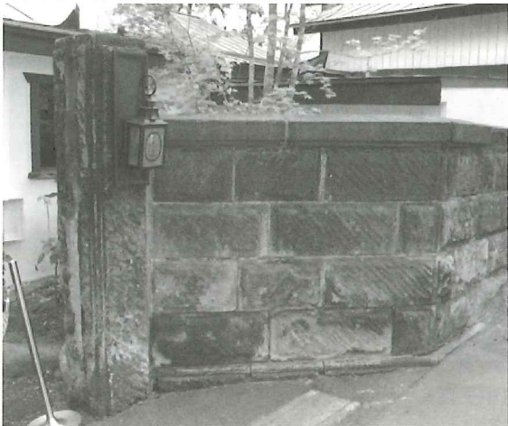
門柱・塀（北区）
