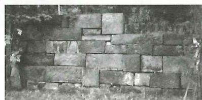
土留め（中央区）
