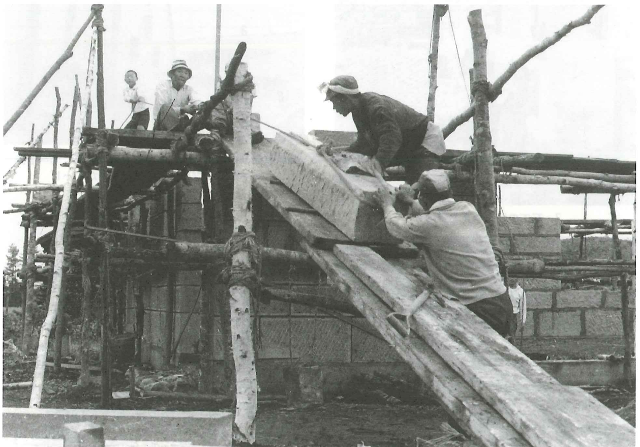
建築現場で軟石を積み上げるようす 1955（昭和30）年頃
