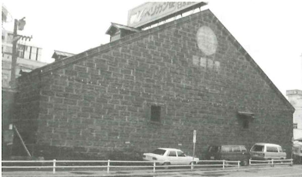
日本通運倉庫 (旧北海倉庫)
