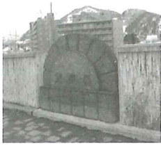
橋の銘板（南区）
