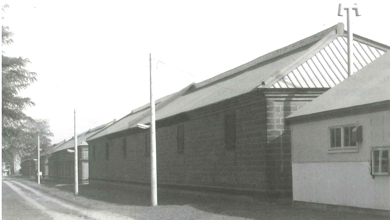
東区-20 陸上自衛隊苗穂支処倉庫
