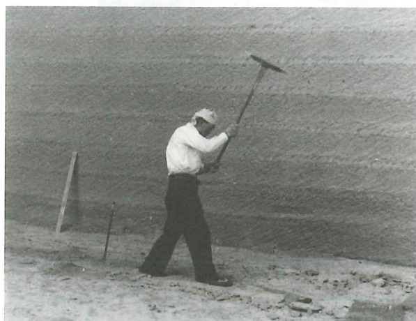
2 ツルで溝を掘る
