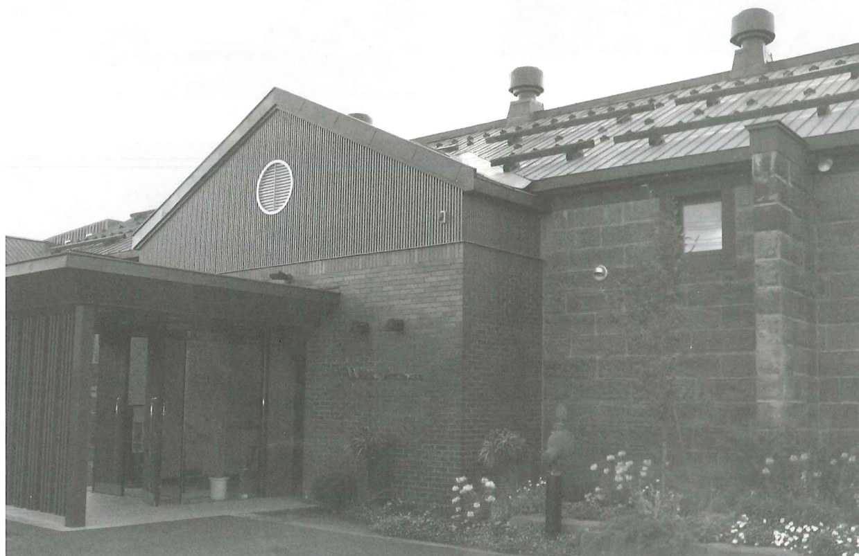
東区-8 メモリアル香華殿 With-House 北 12 *
