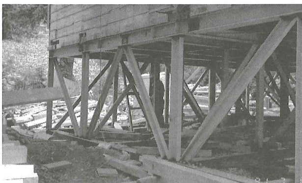
1990～1991年の大改修工事 (土台を鉄骨に交換)
