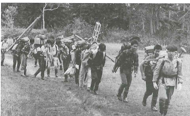
改修資材の荷上げ (1989年6月、伊藤健次氏撮影)
