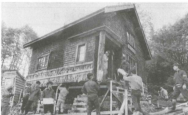
土台交換のためジャッキアップされた小屋 (1989年6月、伊藤健次氏撮影)
