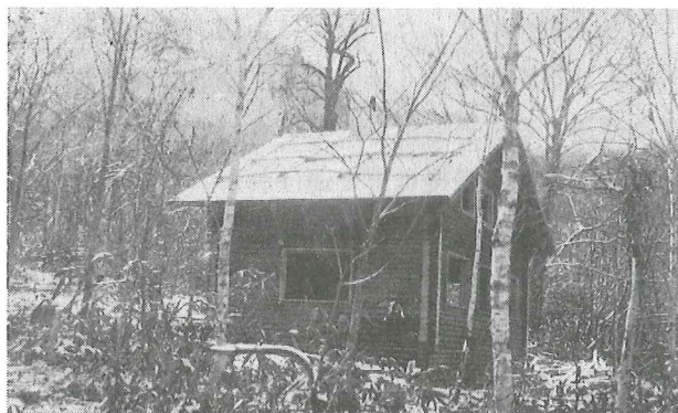
工事中のパラダイス・ヒュッテ (坂本彌直撮影。北大スキー部創立15周年記念号、1926より)
