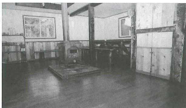
床もフローリングに張り替えた (1989年6月、在田一則撮影)
