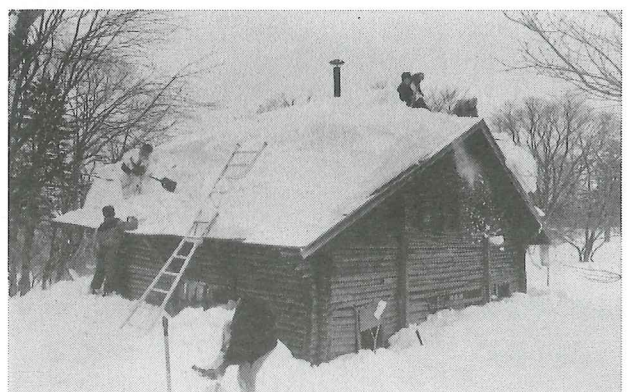
パラダイス・ヒュッテの雪下ろし作業 （1990年1月、伊藤健次氏撮影）
