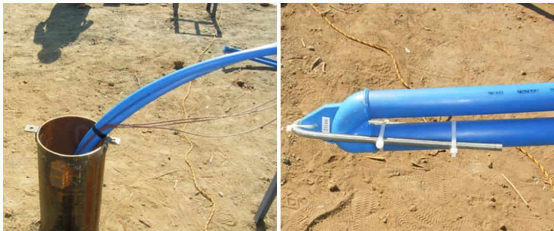
写真 4-1 一般的な U 字管(材質：高密度ポリエチレン管)
