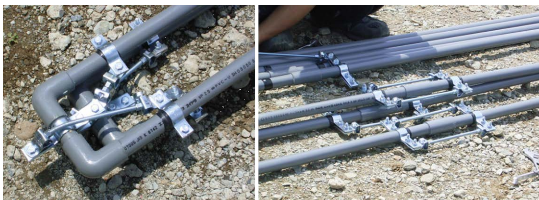
写真 4-2 塩ビ管で作成した U 字管(直管)
