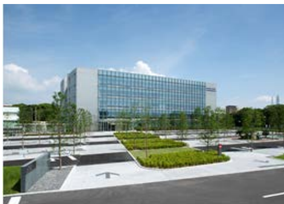
図 5-1 新日鉄住金エンジニアリング(株)北九州技術センターE 館
