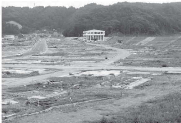
写真5 スーパー堤防が破壊された田老地区 2011年7月 (撮影：筆者)
